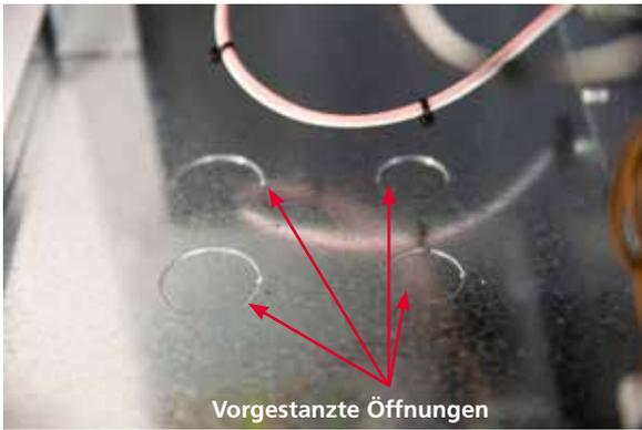
**Bild 13 - vorgestanztes Blech für Kabelverschraubungen**
