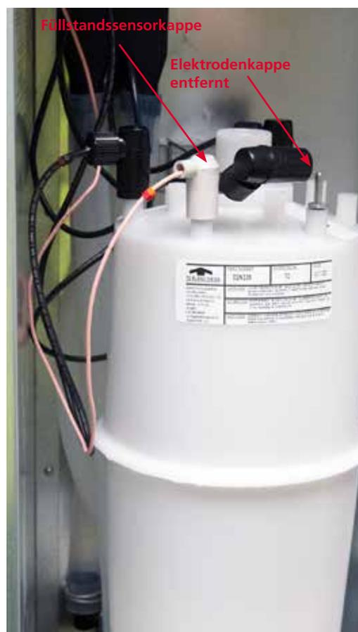
**Bild 15 - Dampfzylinder mit Elektrodenkappen**
