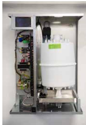
**Bild 2g - Einheit an der Wand montiert, keine Frontplatte**
