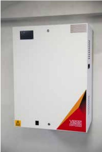
**Bild 2j - Luftbefeuchter montiert mit Frontplatte verriegelt**
