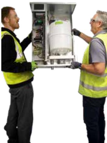
**Bild. 2d - Einhängen des Gerätes auf die Lascheneinsätze an der Halterung**
